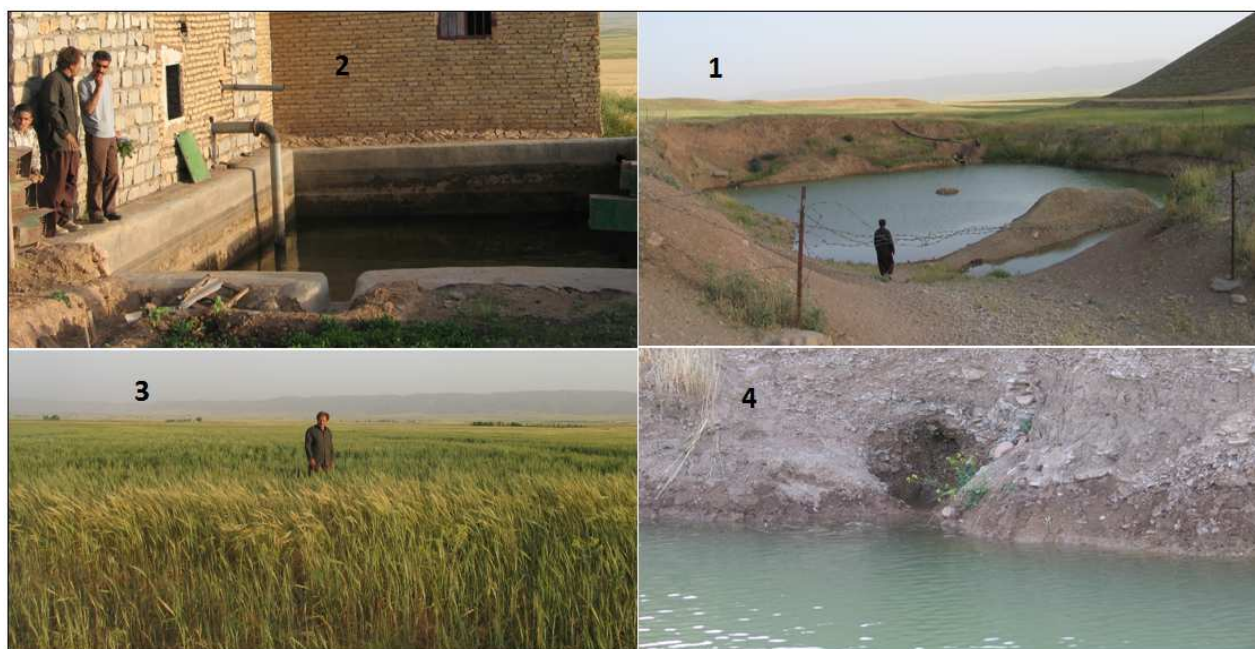
شکل ۲: مراحل چاله ذخیره رواناب سطحی (۱)، پمپاژ آن به استخر سیمانی بالادست مزارع دیم (۲)، "ندم دیم آبیاری تکمیلی با آب استحصال یافته (۳) و نمای نزدیک آب استحصال یافته (۴).
